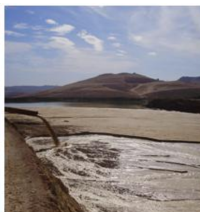
Figure.3 Evacuation et décantation de la boue de dragage
