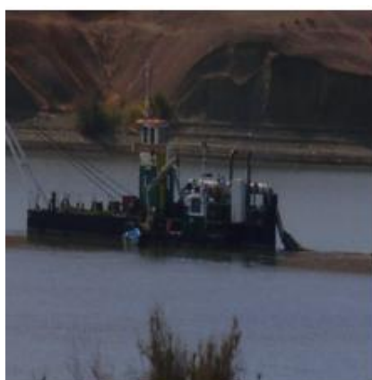
Figure.2 Opération de dragage
