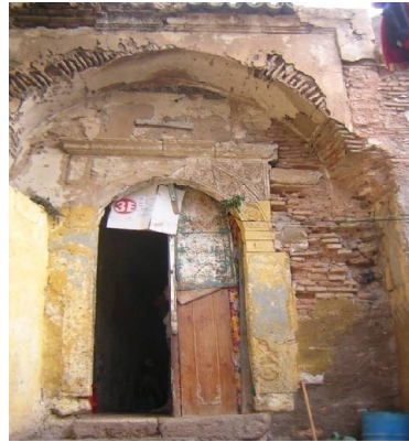
الصورة رقم 03: المدخل الرئيسي المفترض لضريح الباي مصطفى لحر
