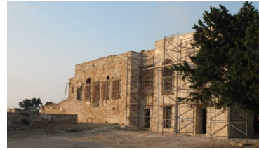
صورة رقم 3- الواجهة الجنوبية
