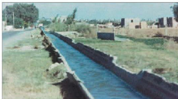
Cliché. 1 : Canal secondaire.
