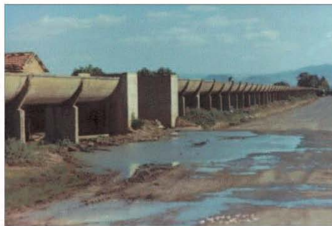
Cliché. 2 : Canal principal.
