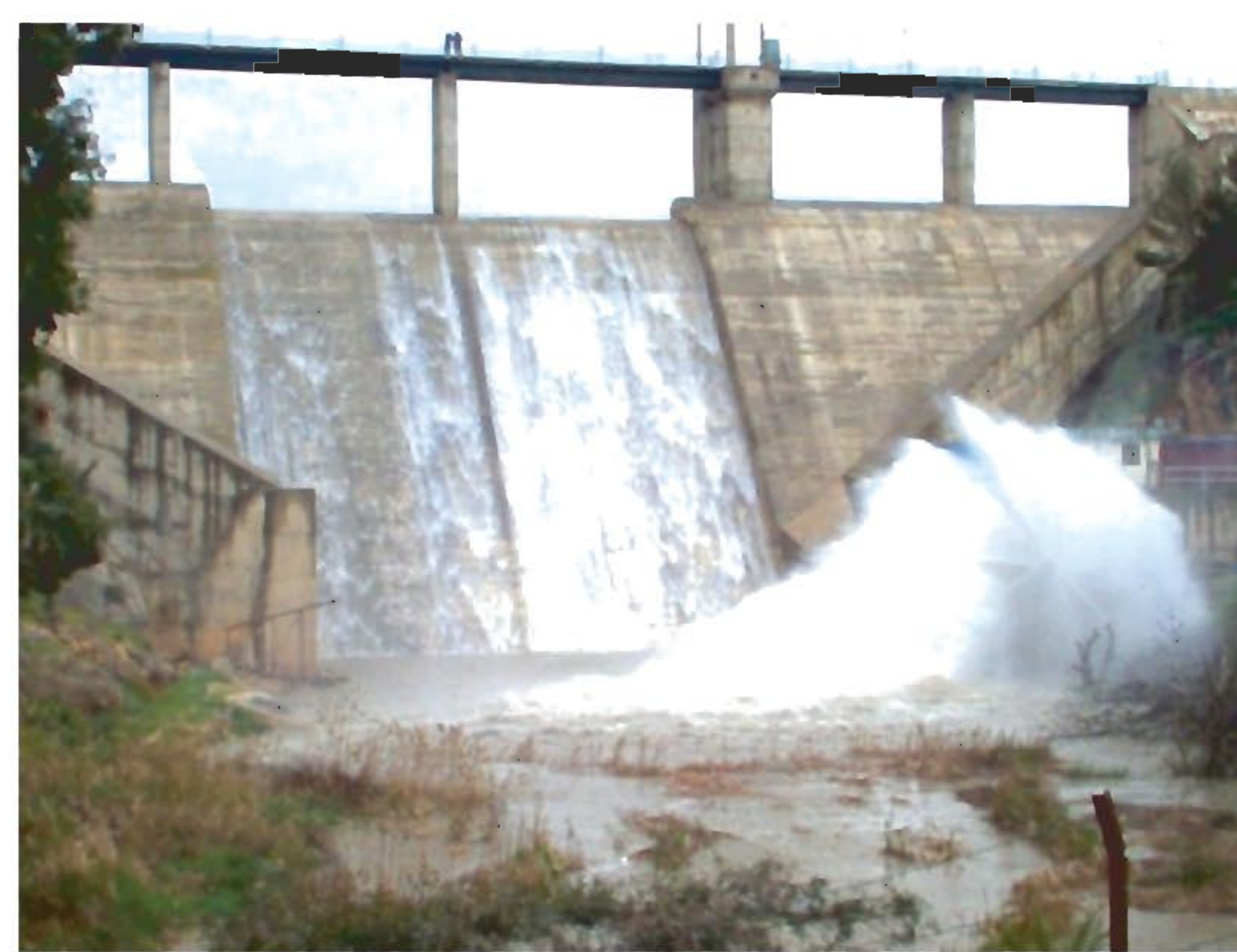
Photo. 2 (ANBT, 11 avril 2005) Vue aval et déversement de crue du barrage de Hammam Grouz
