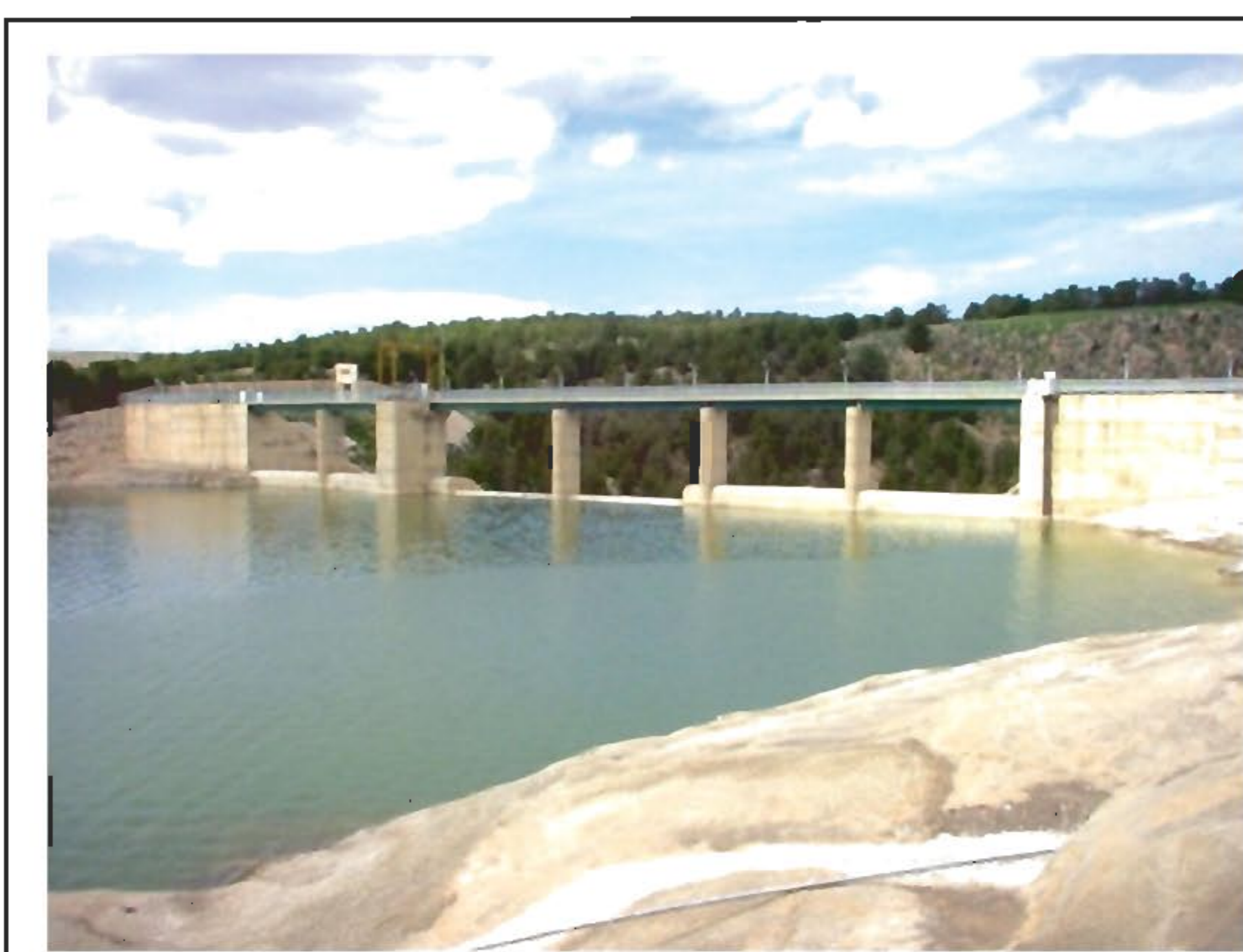
Photo. 1 (ANBT, 29 mars 2005) Vue amont et retenue du barrage de Hammam Grouz
