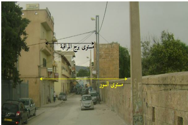
جانب من السور البيزنطي قرب باب سيرتا يظهر لنا ارتفاع المباني السكنية مقارنة بمستوى السور وأبراج المراقبة
