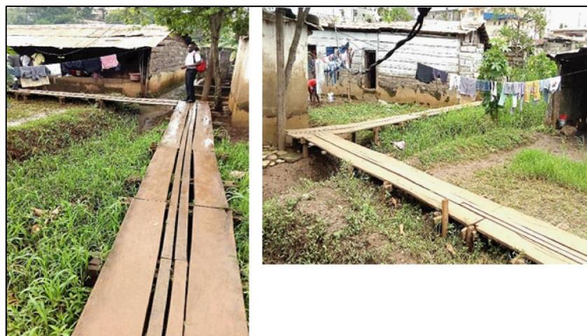
**Figure 11 : Vue du pont d'accès aux maisons d'habitation construit en planches de bois à Elig-Edzoa**
