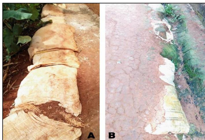
**Figure 9 : Vue des sacs remplis de terre relevant d'une hauteur les berges d'une rigole à Melen (A) et à Mfandena (B). Clichés : Djatcheu, 2015.**
