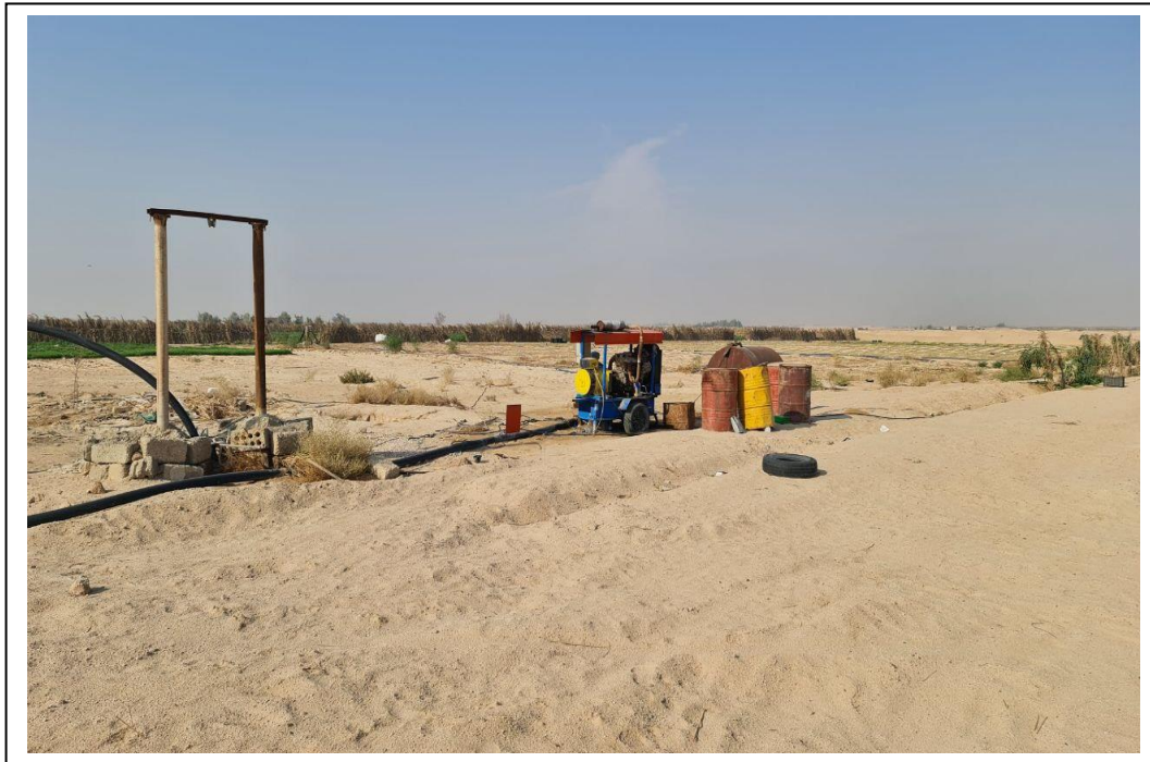
شكل رقم (6) يبين صورة لمولدة تعمل بزيت الغاز سعة التوليد 30 كي في
