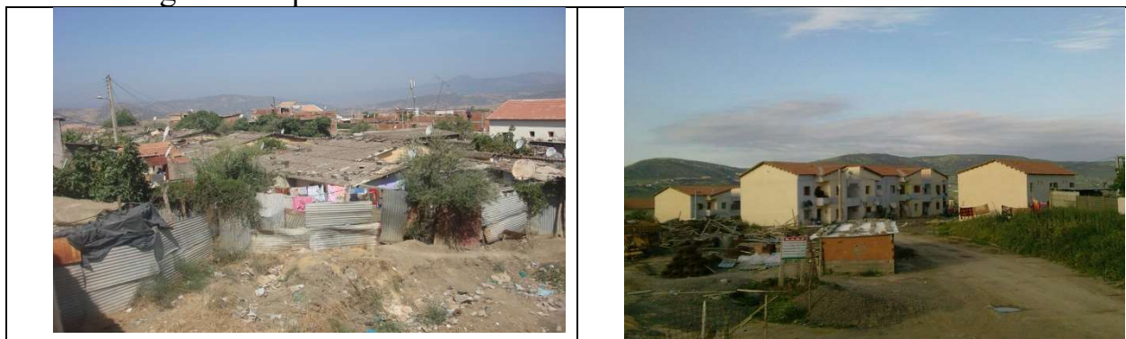
Figure.08. Photos prises avant la démolition du Quartier SAS et les habitations à reloger (2logements sociaux locatifs (RHP))
