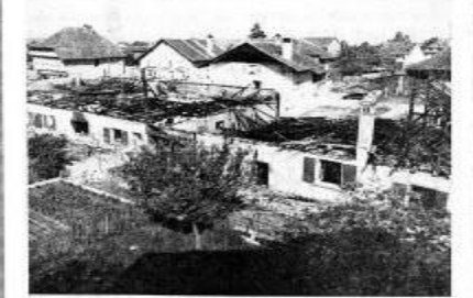
Un incendie horrible a détruit, samedi à l'aube, quatre bâtiments situés à Corcelles-sur-Payerne (voisins d'Orbassens), dans le canton de Vaud. Les dégâts s'évaluent à plus de 400.000 fr. Votre photo montre le théâtre de ce gigantesque sinistre.
