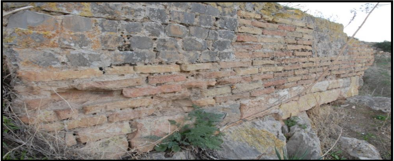
صورة رقم 01: توضح جدار لمبنى سميك مبني بالتقنية المختلطة في ماستر (إعداد الباحث)
