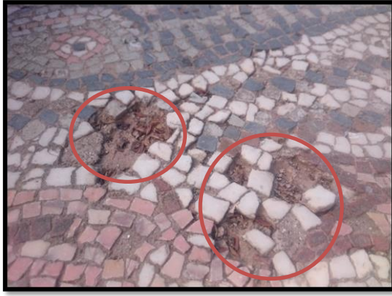
الصورة رقم (11) تمثل فقدان مكعبات فسيفساء حوض الأسماك
