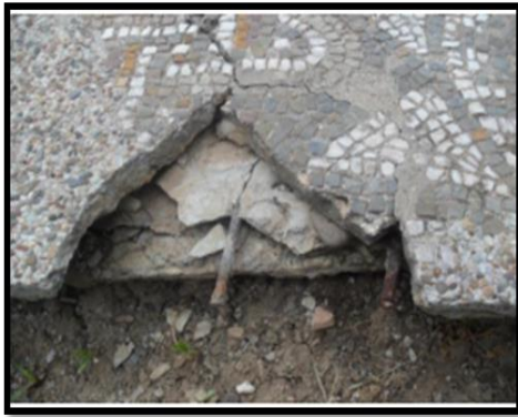
الصورة رقم (13) تمثل فقدان جزء من حامل المدعم لفسيفساء الطاووس
