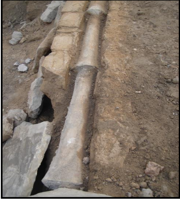
الصورة 6 قناة صرف المياه فخارية
