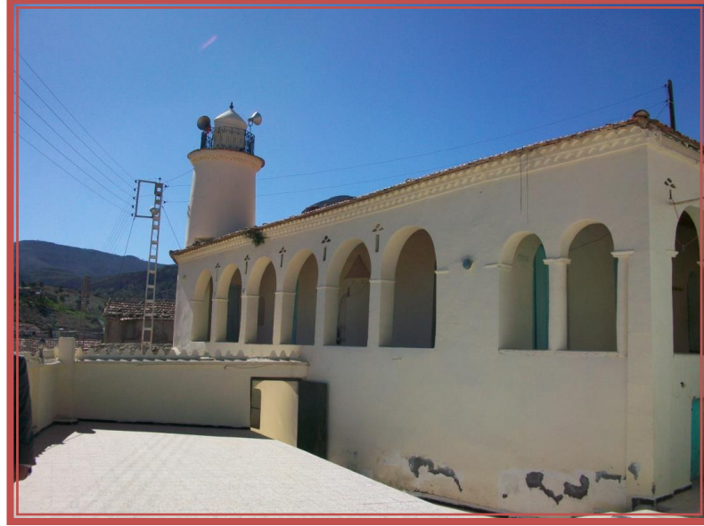
الصورة أ: مسجد أولاد سيدي إبراهيم الواجهة الشمالية الشرقية (بلدية المنصورة)
