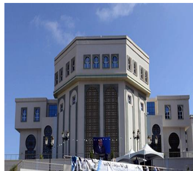
Figure N° 6. Façade intérieure de l'ESSS
