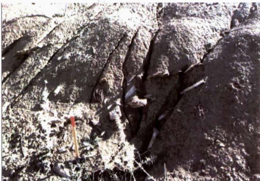
Photo 6 - Marnes miocènes à lamelles de gypse remplissant les fractures. Versant nord d'Aïn el Bey
