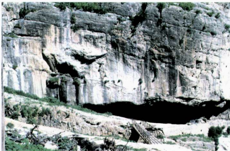
Photo 14 - Miroir de faille verticale N130°E mettant en contact le calcaire néritique et le tellien, sous le pont de Sidi Rached (rive droite du Rhummel).
