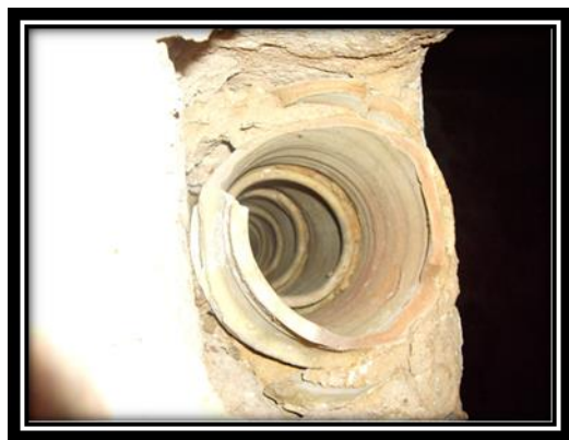
الصورة رقم 09: كيفية وضع القنوات الصرف
