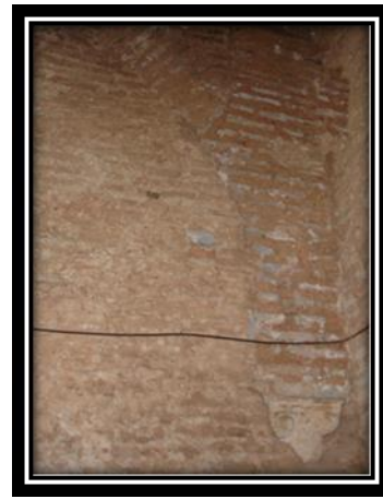
الصورة رقم 05: كيفية استعمال الآجر في الحنيات
