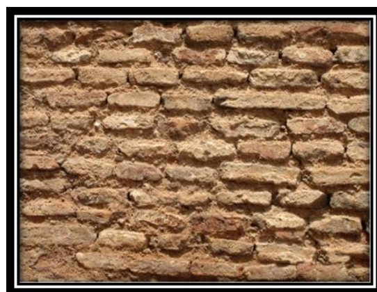
الصورة رقم 01: كيفية بناء الأسوار بالآجر
