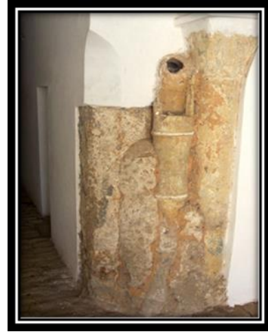
الصورة رقم 10: كيفية وضع القنوات الصرف ما بين الأعمدة
