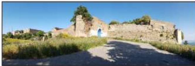
Photo 6 : Vue extérieure de la Citadelle Source : Auzer 2017
