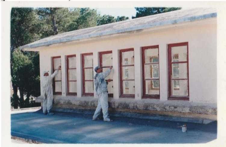
Travaux de restauration de la dalle du musée et ses lanterneaux, 1999.
