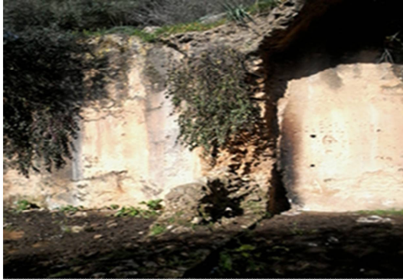
الصورة 4: حوضي خزان المياه
