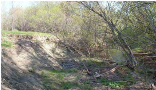
Fig. 1. Glissement rotationnel dans un talus de 4 m de hauteur et dont l'escarpement arrière occupe un angle de 52^\circ sur 1.5 m de hauteur.
