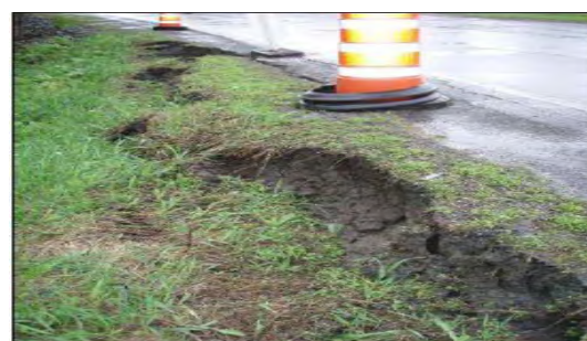
b)- état de l'accotement en 2011
