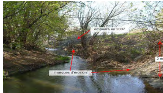
Fig. 4. Empiètement des débris dans la rivière Saint-Jacques. Marques importantes d'érosion à l'avant-plan et empièchement à l'arrière plan.
