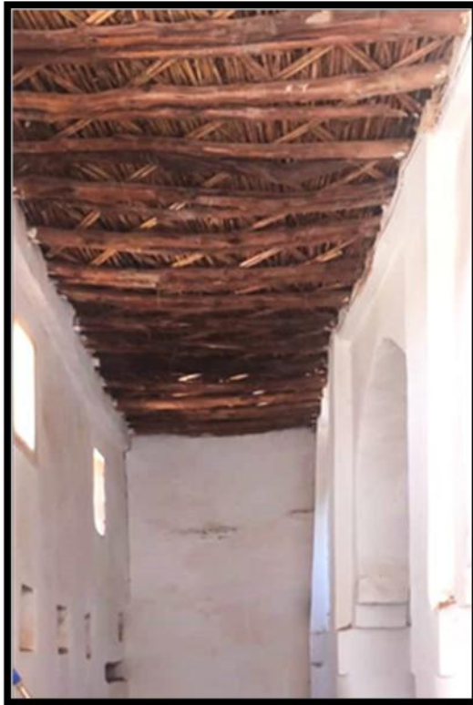
الصورة12: استعمال الخشب في تسقيف المسجد
