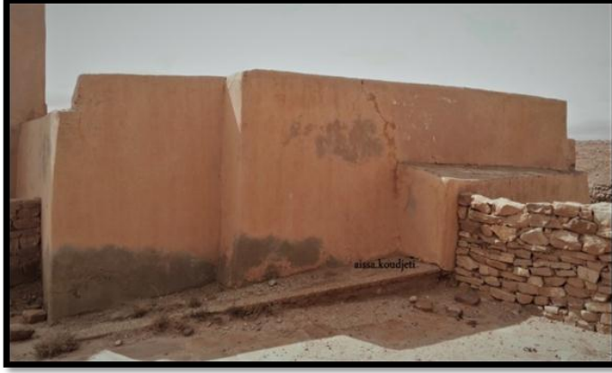
الصورة 03: الواجهة الشمالية للمسجد
