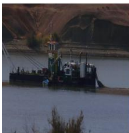
Figure.2 Opération de dragage
