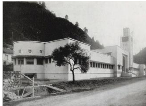
Figure N° 5. Vue des thermes réalisés à Melouane
