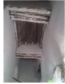
Fig.51: Rondins de bois en berceau rampant M12
