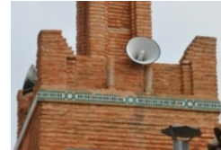
Fig.46 : Parapet à merlon sans lyse intermédiaire, M6, M4, M8
