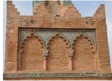
Fig.46 : Parapet à merlon sans lyse intermédiaire, M6, M4, M8
