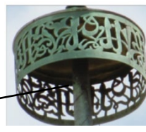
Fig.10: Couronne de l'épi de faitage, M4
