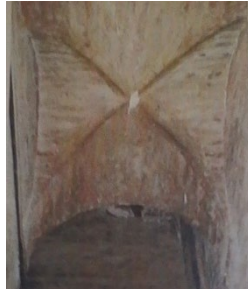
Fig. 49: voûte d'arête terrasse du minaret, M10
