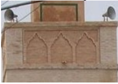
Fig. 45 : Parapet sans merlon, Sp10
