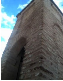
Figure 35: Vue extérieure sur baie, M6
