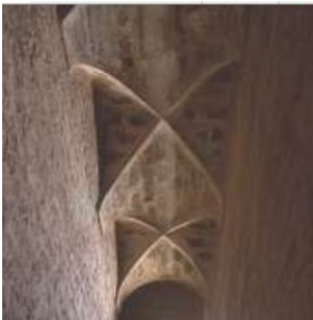
Fig.48 : Vue intérieure sur la voûte d'arêtes, M3
