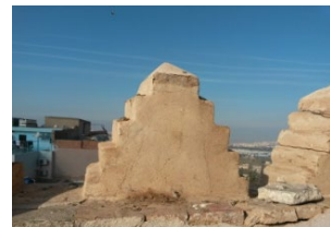
Fig.47 : Particularite des merlons Ziyanides, M3, M6 et M12
