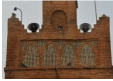
Fig. 45 : Parapet sans merlon, Sp10
