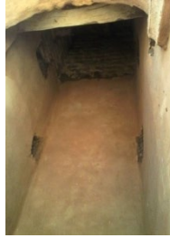
Figure 36: Vue de l'intérieure de la niche, M6
