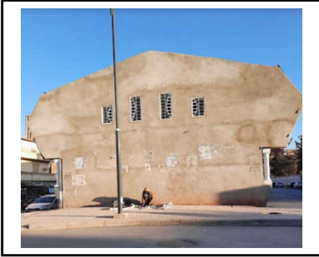
3. Façade latérale droite en béton avec quatre petites ouvertures.
