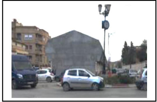
4. Façade latérale gauche en béton muette.
