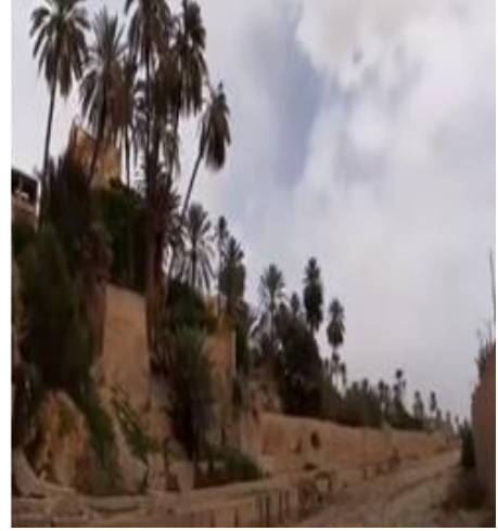
الصورة (03): سكنات بحافة واد بوسعادة
