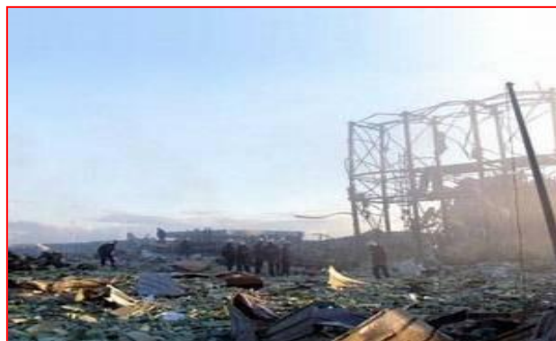
Photo N°06 : Photo après l'explosion du GNL de Skikda
