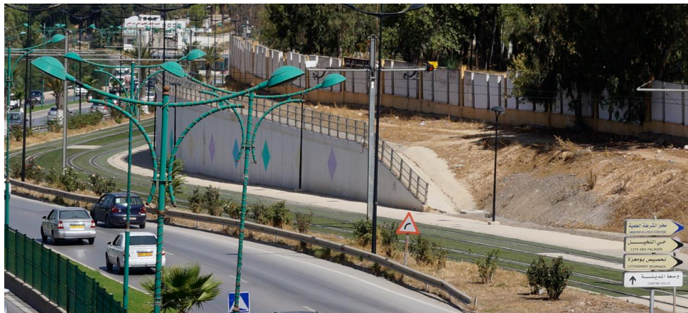
Photo 8 : Tapis de Gazon artificiel sur la plateforme de la ligne du tramway
