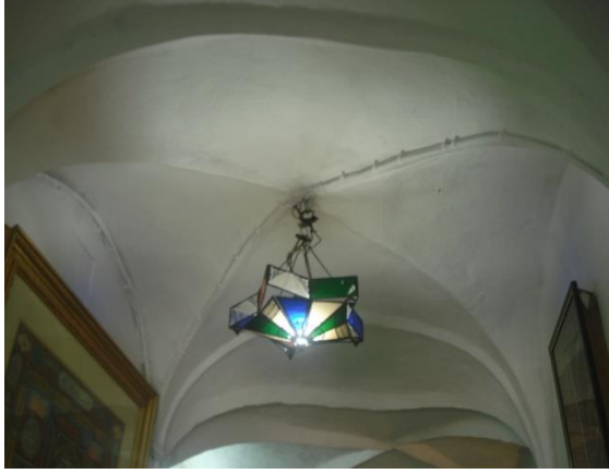
صورة 2/ زاوية سيدي عبد الرحمن الثعالبي - القبو المتقاطع
