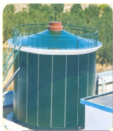
Photo 3. Digesteur industriel à Hammam Sousse
