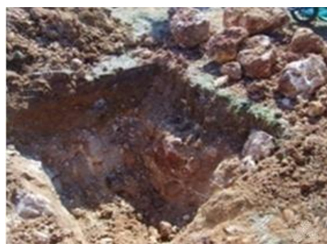
Photo 9 : Potet superficiel sur dalle
