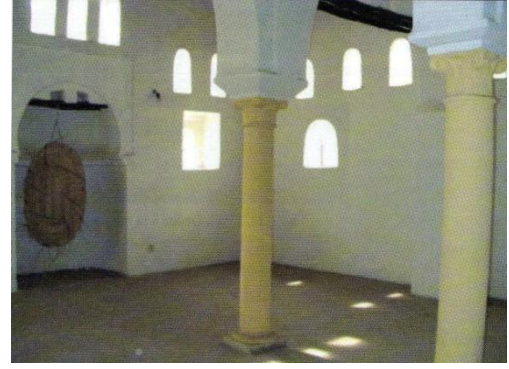
الصورة 01 : المظهر الداخلي لضريح سيدي هلال
