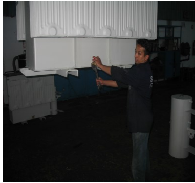
photo n° 17 : serrage des boulons
