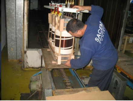
Photo n°15 : étuvage de la partie active
