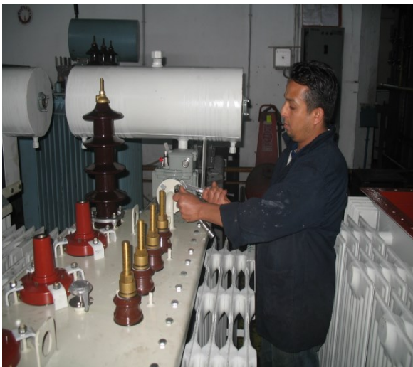
Photo n°18 : Montage des Accessoires
