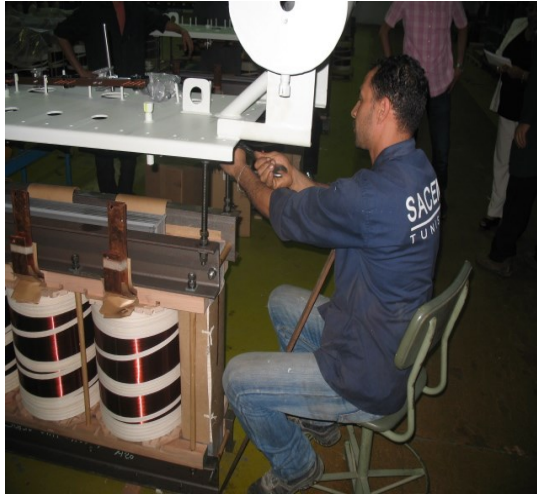
photo n° 12 : Montage des traversées Basse Tension (BT) et câblage BT
