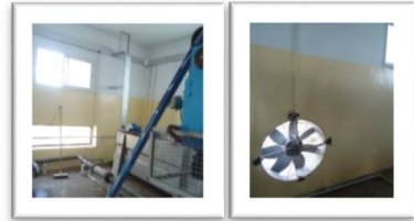
Photo 2/3 : installation de fenêtres et d'extracteur bas situés
