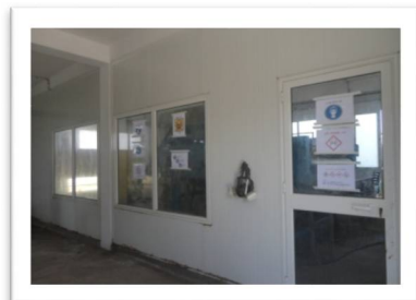
Photo 4 : Séparation entre la presse et le reste de la salle
