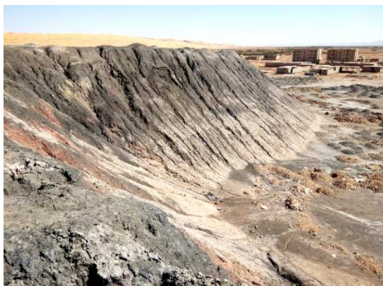
Fig 17. Terril du lavoir (Hauteur≈30m)
