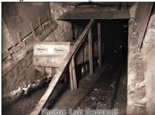
Fig 08. Remontée du wagonnet du charbon
