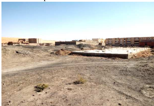
Fig 22. Lotissements d'habitations individuelles à proximité des terrils
