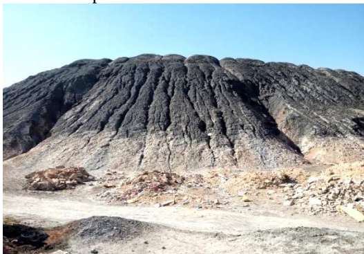
Fig 21. Ravinement par ruissellement des flancs du terril de lavoir
