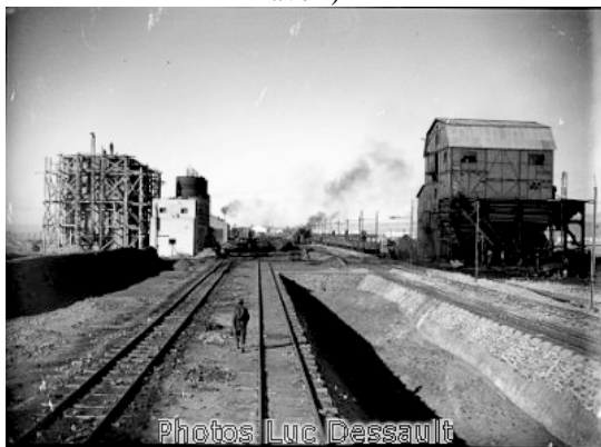
Fig 03. Houillère de Kénadsa (les installations de lavoir)
