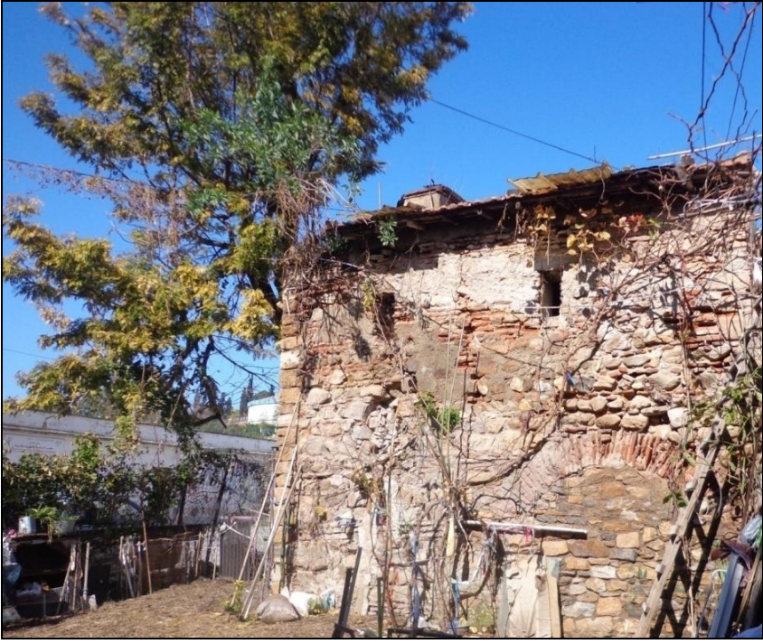
الصورة رقم (05): الواجهة الجنوبية لحصن المعدين
