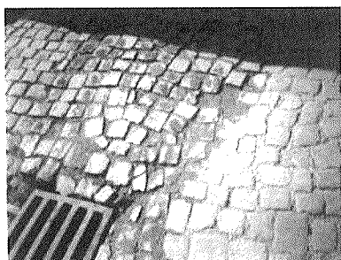
Figure 6 : Dégradation avancée de la voirie et réseaux d'assainissement
