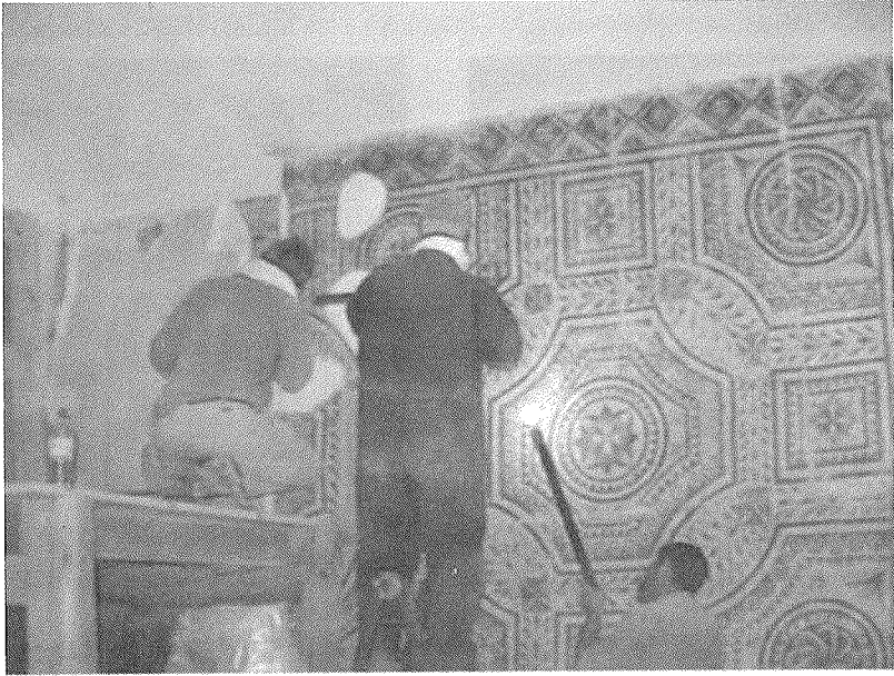
الصورة 05 : تمرير الصفائح الحديدية وراء الفسيفساء.
