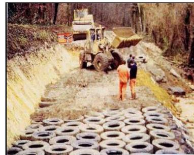
Figure 4. La technique de Pneusol, Le chantier Cannes-Mandelieu en 1988.
