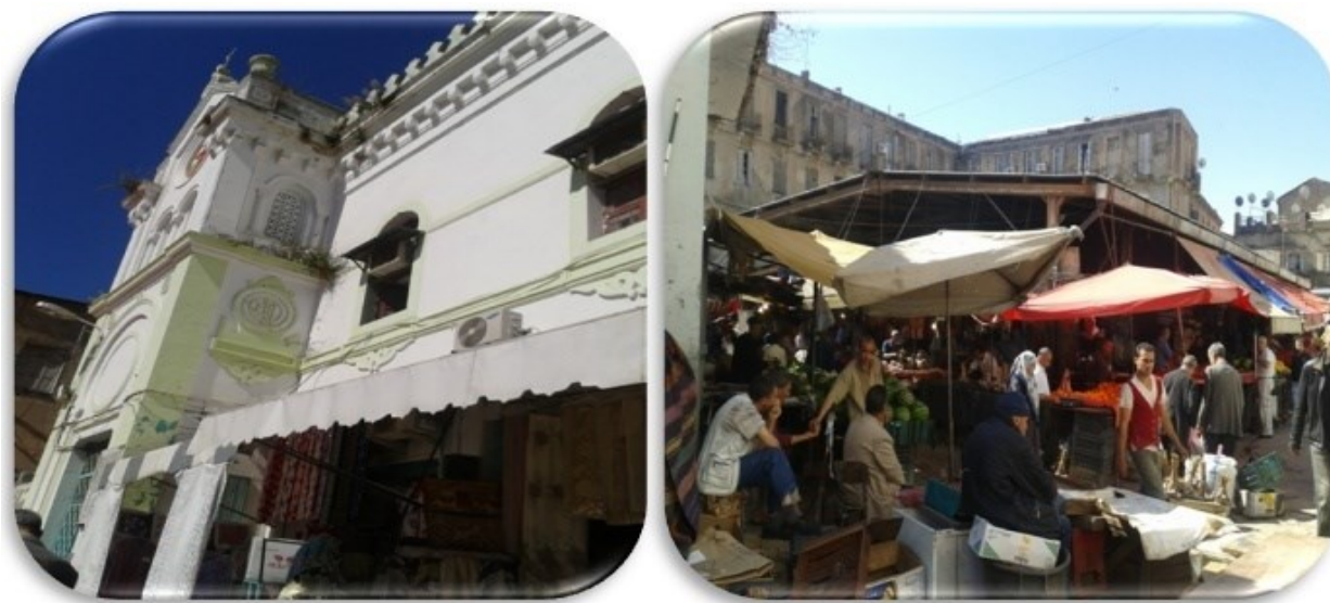
Photo n°01 et 02 : Les façades cachées et l'état de dégradation du marché. Source : Auteur
