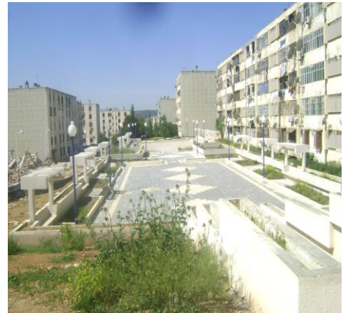
Photo n° 4 : l'aménagement d'une place publique
