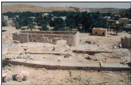
Fig. 3 – Béton banché coulé sur la roche Source : association Touiza
