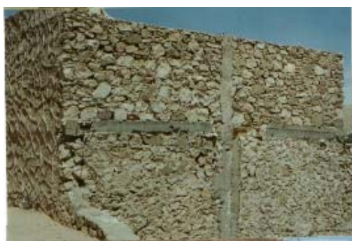
Fig.16- Mur porteur en pierre avec raidisseurs
