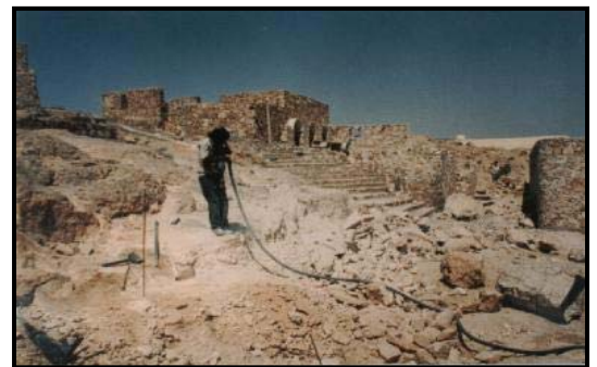
Fig.2 – Mise en place des fondations
