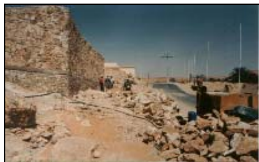
Fig. 5– Mur extérieur avant la finition Formant l'enceinte extérieure. Source : association Touiza 2003
