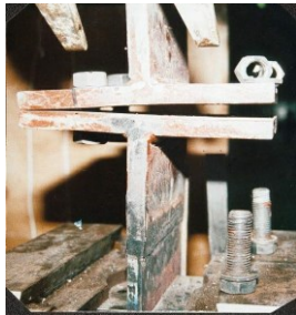
Photo 5 : Ruine de l'assemblage par rupture des boulons- tp=15mm
