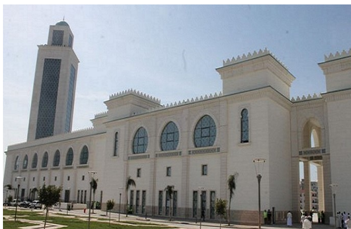
Photo02 : vue sur la façade
