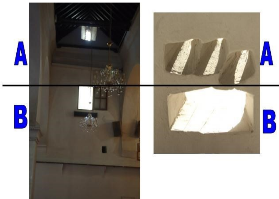
Figure 3 : rapport lumière creusée et forme de baie, nous pouvons remarquer que les trois trous du hauts (A) ne laissent passer que très peu de lumière, à l'inverse du trou inférieur (B) créé également de trois ponts de vue différents
