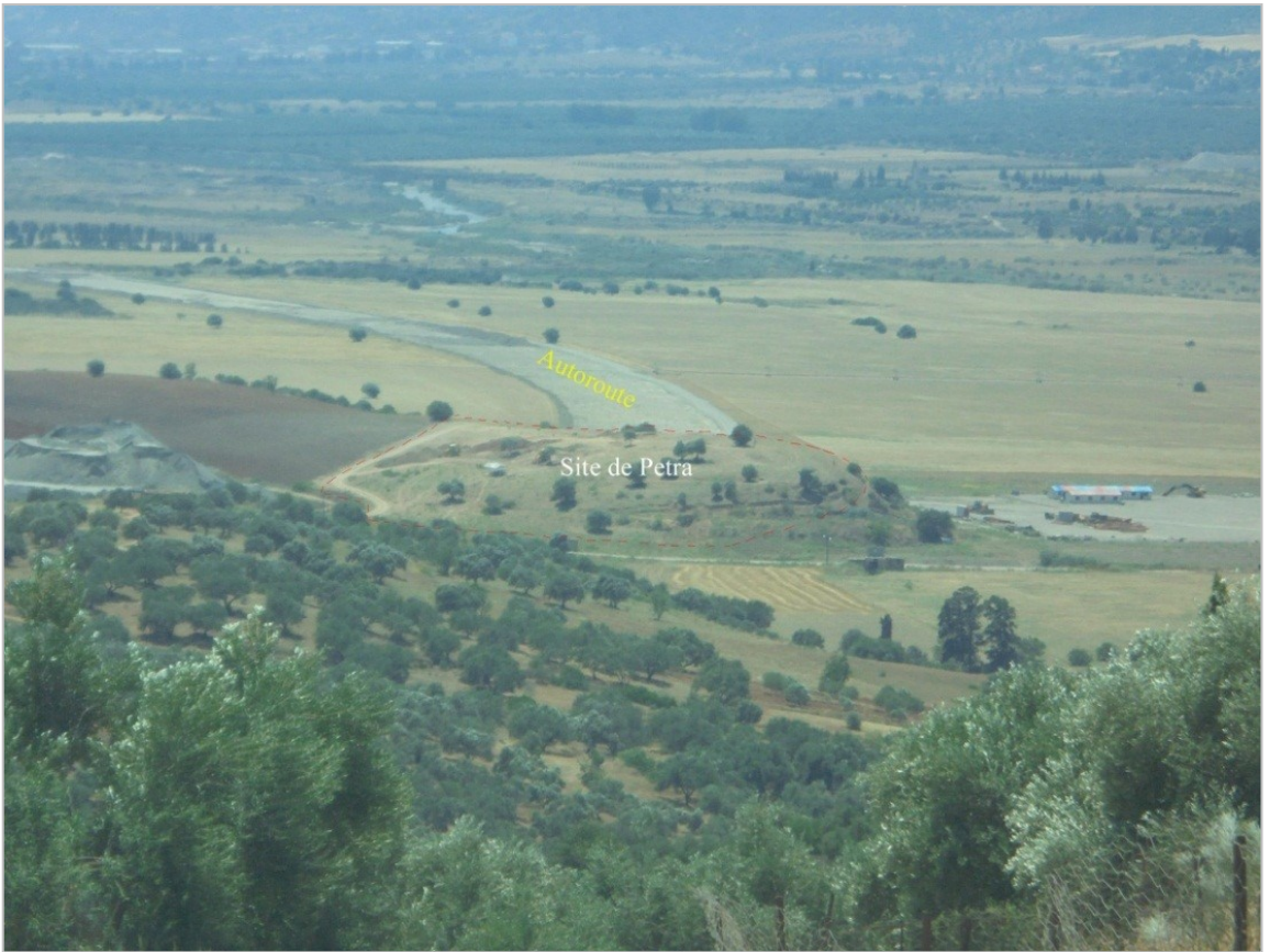
Photo n° 1 : Vue sur le site (encadré en rouge).
