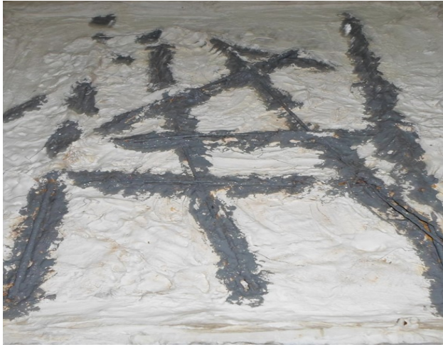
الصورة رقم (10): استعمال مضاد للأكسدة على القضبان الحديدية.
