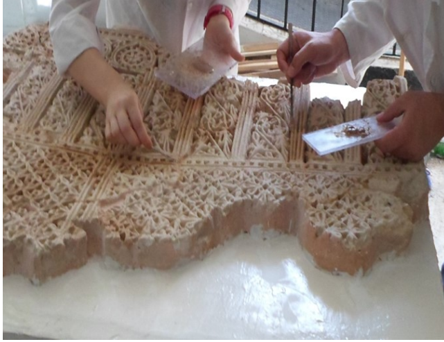
الصورة رقم (12): تقوية الشقوق على سطح الزخرفة.
