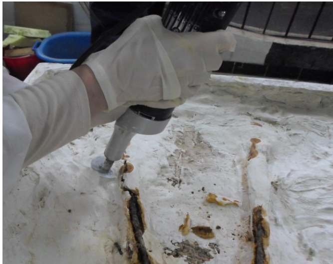
الصورة رقم (07): توضح نزع الجبس المضاف للتخلص من القضبان الحديدية.
