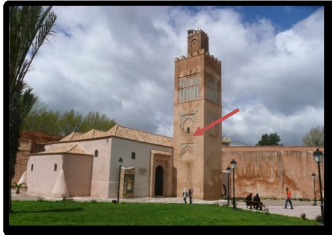
الصورة رقم (01): تمثل مسجد المشور ومئذنته المزخرفة بقطع الزليج
