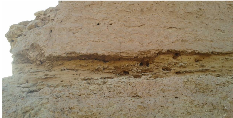
الصورة رقم (3): توضح تأثير الرياح على المباني الطوبية
