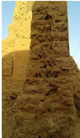
الصورة رقم (1): تبين الفرق في سمك الجدران كلما ارتفعنا عن الأرض
