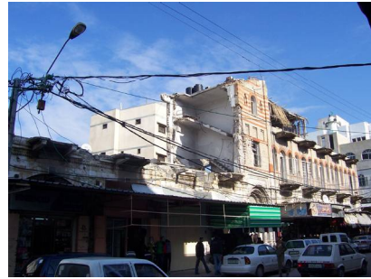
لقطة من مبنى محكمة البلدية من الأمام (الواجهة الجنوبية المطلة على شارع عمر المختار)
